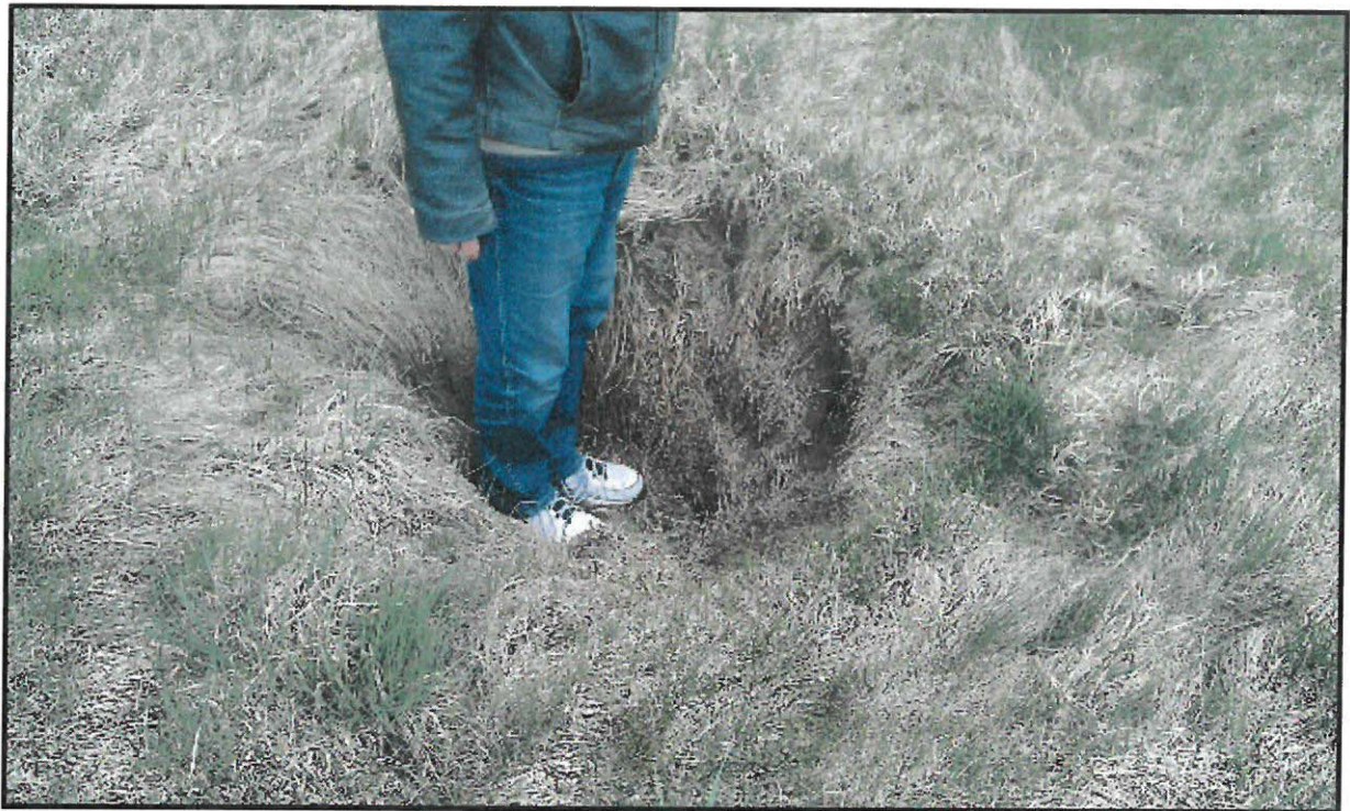
Rys. 1. Uszkodzony drenaż w pkt. 1.
